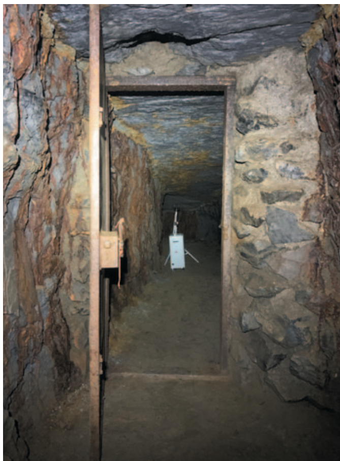
Obr. 1. Měření proudění vzduchu ve štolě v jeskyni Býčí skála.
